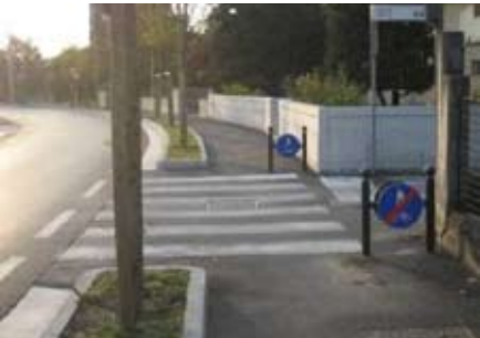
Esempi per segnalare il rischio di uscita automezzi dai passi carrai
