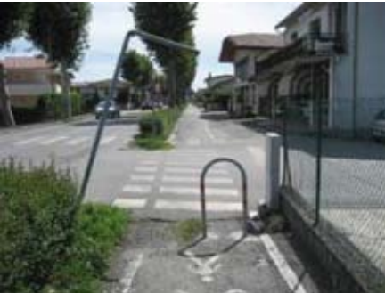
Situazione di degrado.
