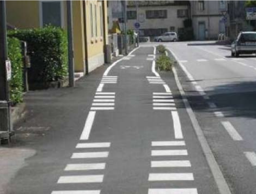
Esempi per segnalare il rischio di uscita automezzi dai passi carrai
