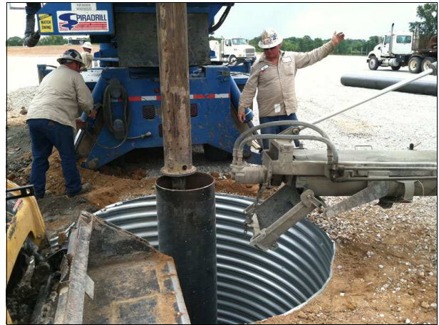
Figura 7 – Esempio di operazione di infissione
