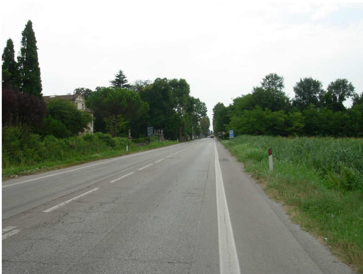
Foto n. 2 – Strada Statale n. 13 – tratta sud, direzione sud
