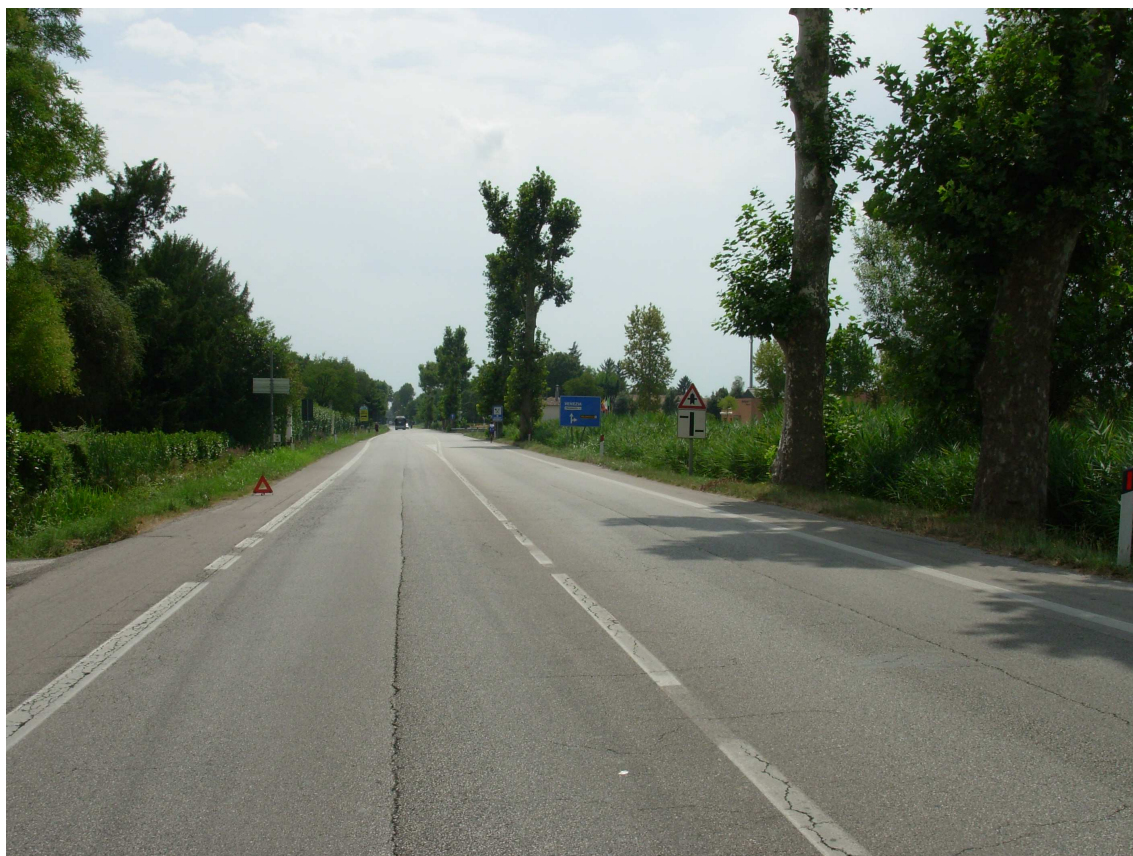
Foto n. 1 – Strada Statale n. 13 “Terraglio” (tratta nord, direzione sud)
