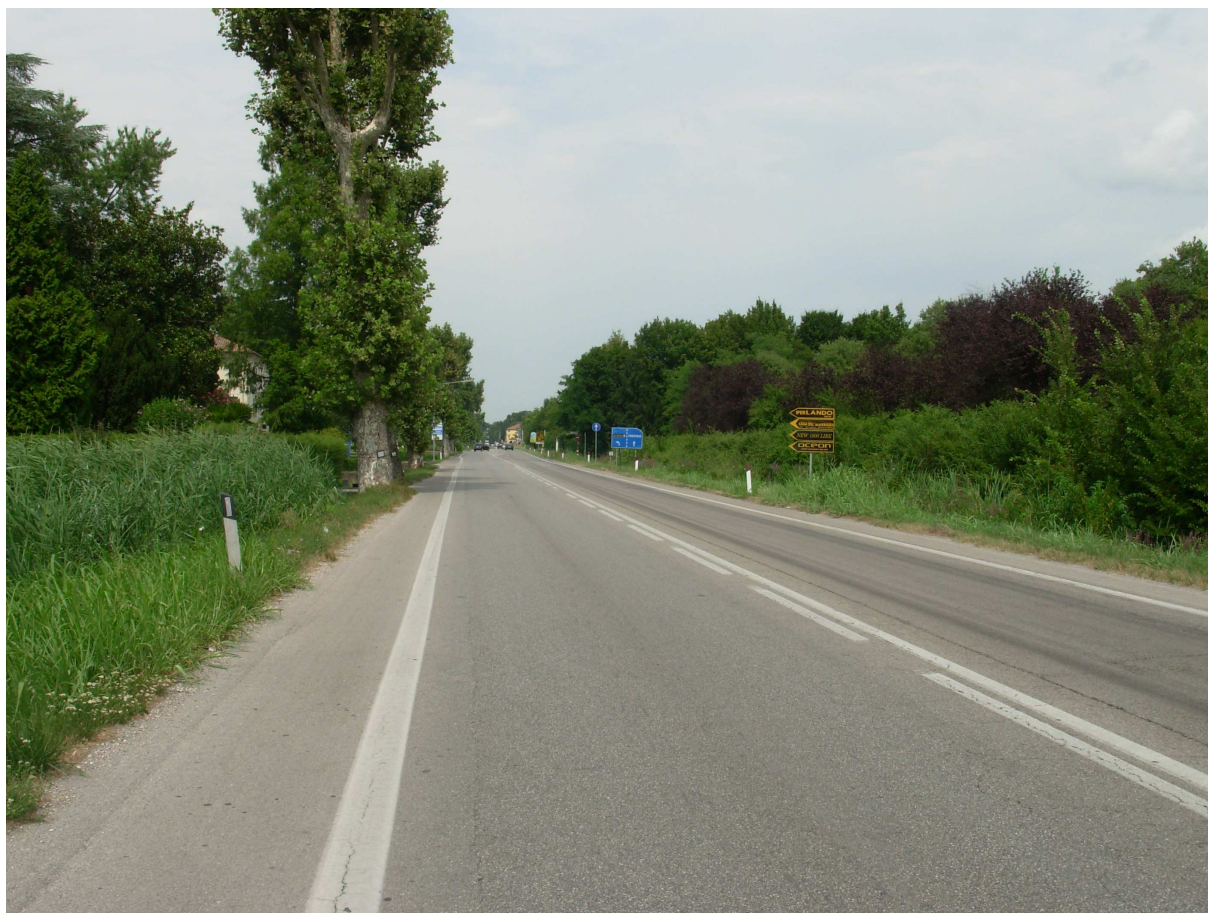
Foto n. 3 – Strada Statale n. 13 – tratta sud, direzione nord
