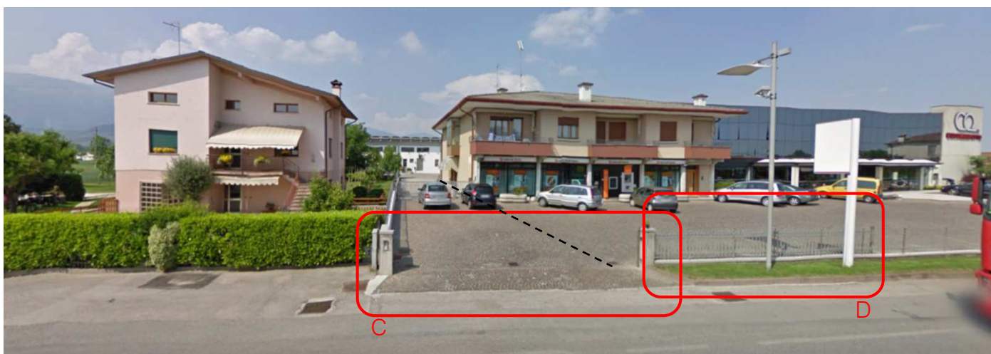
Fig. 37. Ripresa fotografica dell'attuale accesso (C) da spostare leggermente a destra, nel punto (D). Con linea tratteggiata nera è indicato il limite indicativo di progetto tra il parcheggio e il piazzale di carico-scarico a ovest (è previsto l'abbattimento dell'edificio residenziale sulla sinistra).
