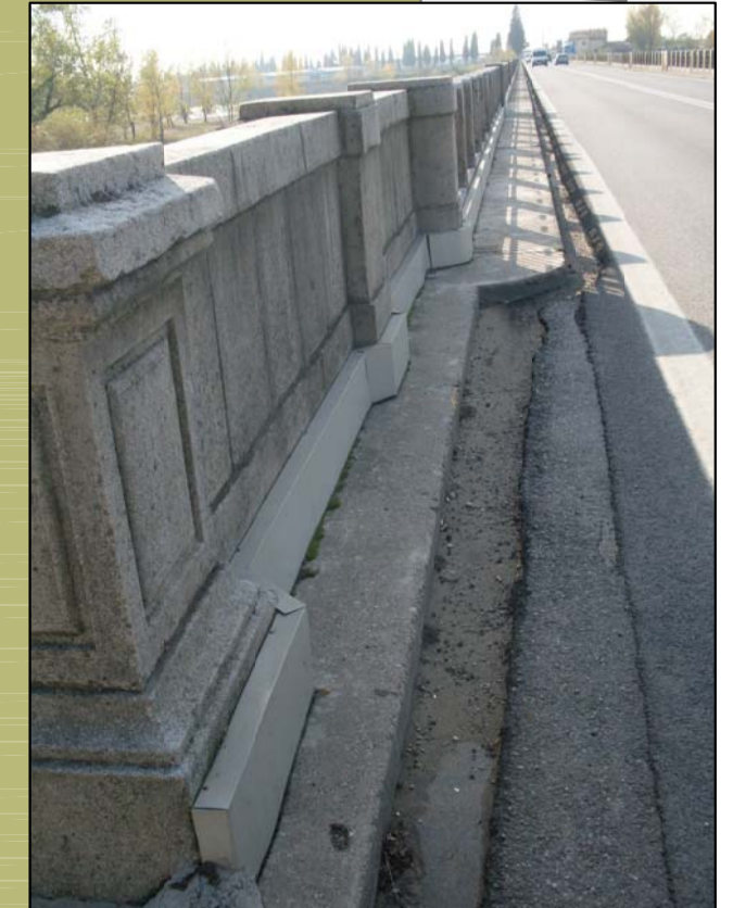
FOTO 5 - canale linea INTERROUTE
