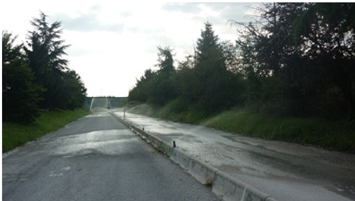
Foto 3: Irrigatori ingresso strada Cava.
