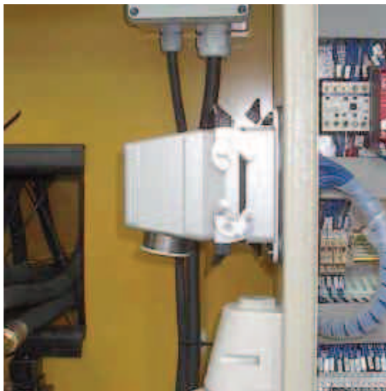
Figura n° 56 Connettore di collegamento consolle/radiocomando
