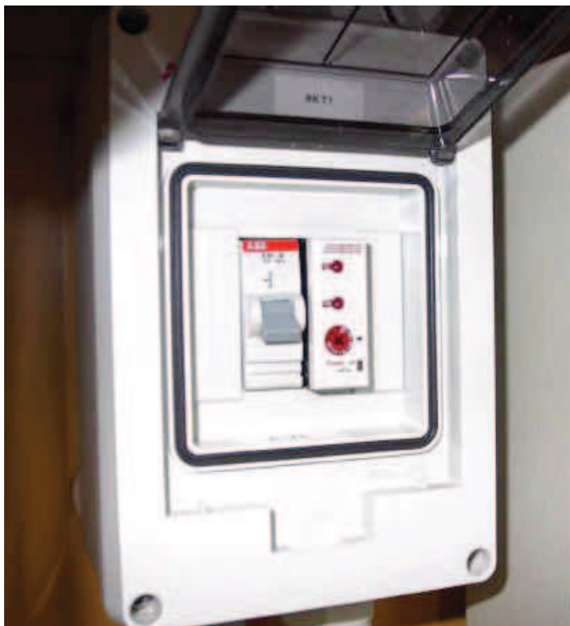
Figura n° 72 Temporizzatore all'interno della centralina idraulica
