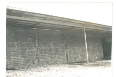
Immagini stato di fatto della tettoia anno 1978 circa
