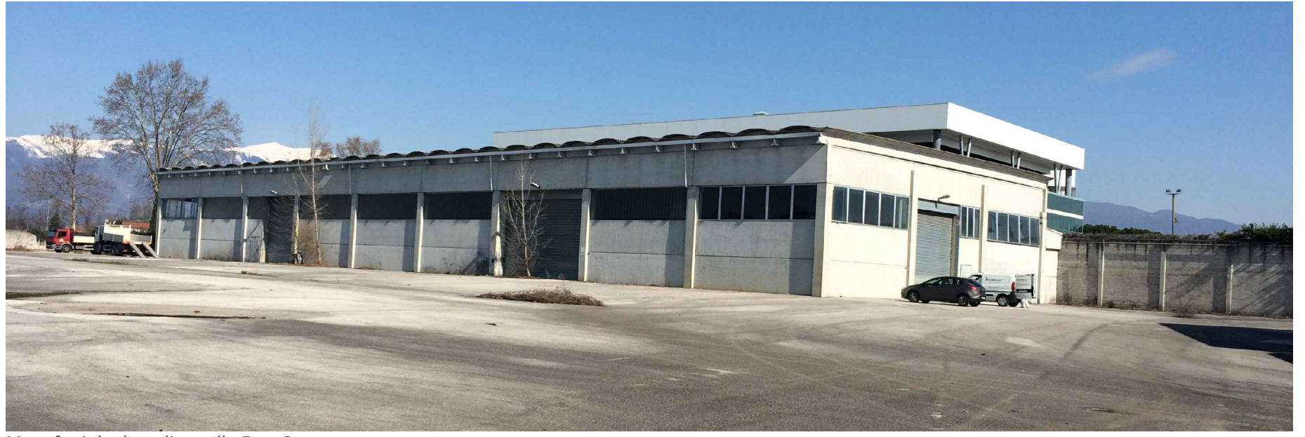
Manufatti da demolire nella Fase 2
