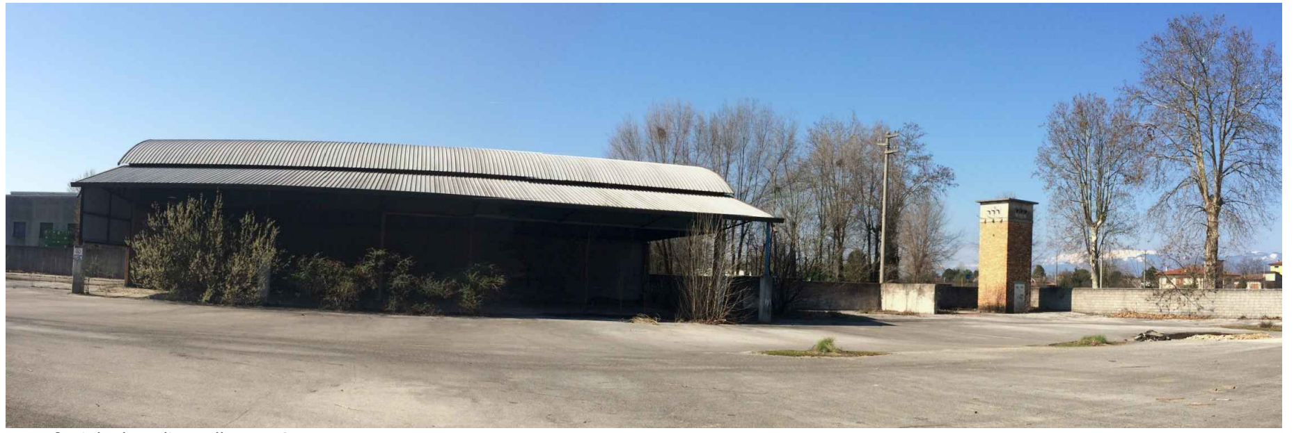
Manufatti da demolire nella Fase 3
