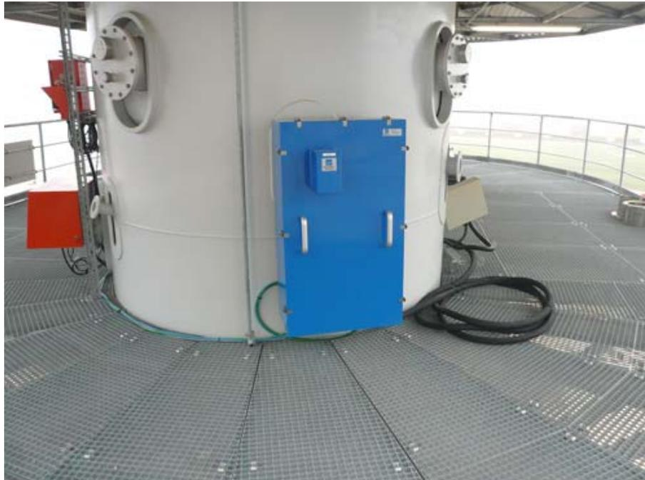
*Figura 5: Esempio di installazione di campionatore continuo di PCDD/PCDF*
