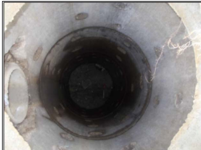
Figura 2-C – Foto pozzo perdente.
