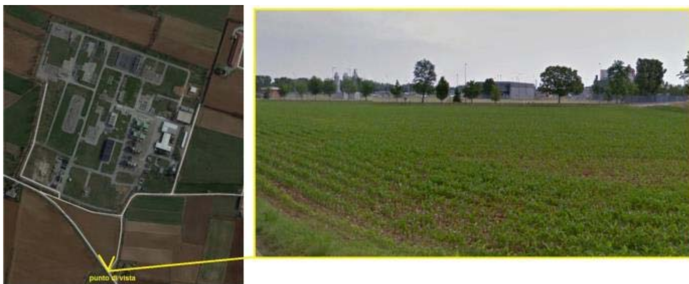
Figura 2.1-1 Vista aerea e foto panoramica dell'Impianto di compressione gas di Istrana (da Google Earth)
