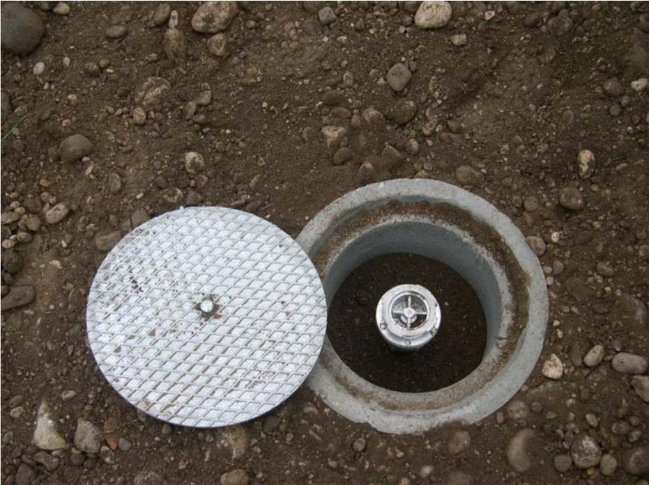
**Pozzetto con testa d'idrante per la consegna dell'acqua.**
