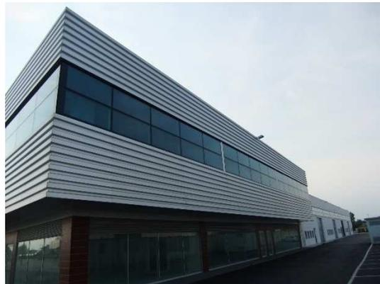
Foto 03 - vista del rivestimento esterno di facciata in alluminio grecato sulla parte a due piani fuori terra
