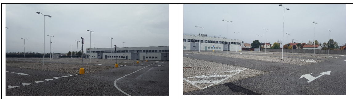
Foto 7 Viste dell'area esterna a parcheggio disponibile oltre a quello dovuto dalla normativa vigente
