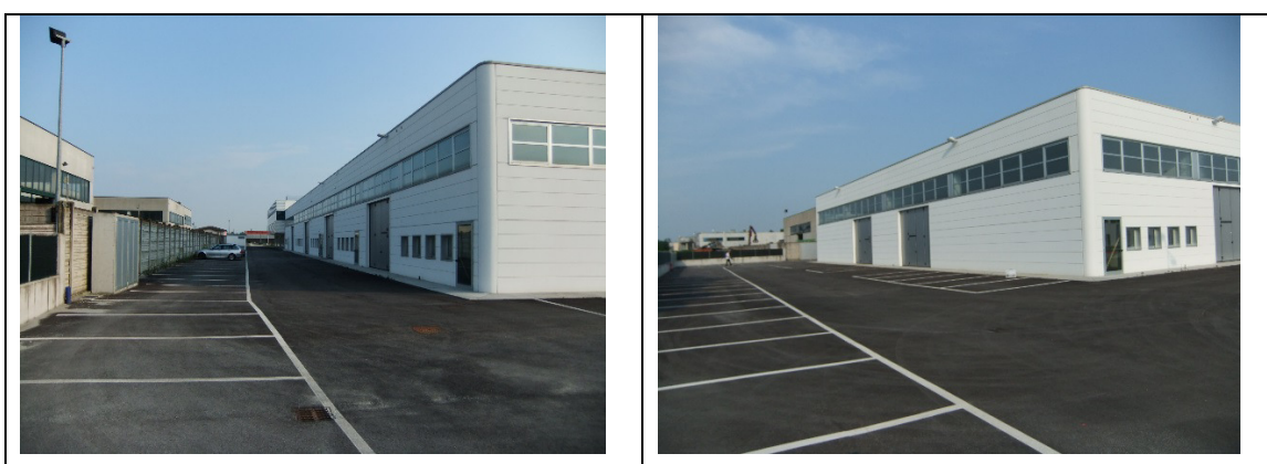
Foto 5 Viste dell'area esterna a parcheggio riservata alle attività artigianali
