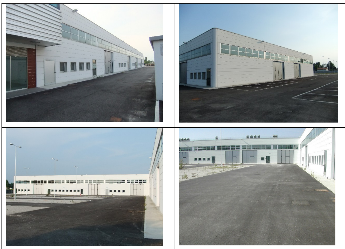
Foto 3 Vista delle facciate perimetrali con accessi alle unità artigianali al piano terra
