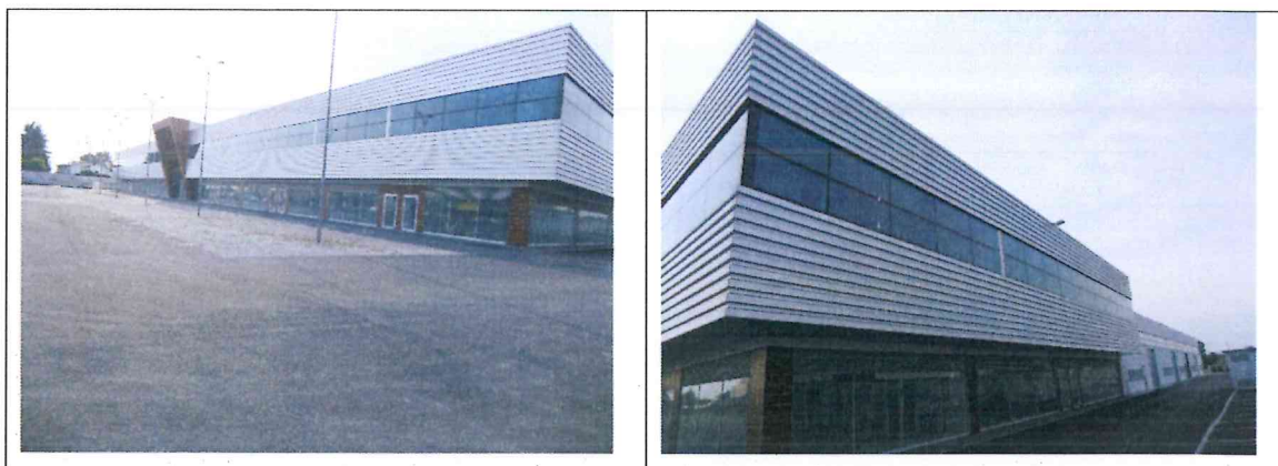
Foto 2 Vista del rivestimento esterno di facciata in alluminio grecato sulla parte a due piani fuori terra
