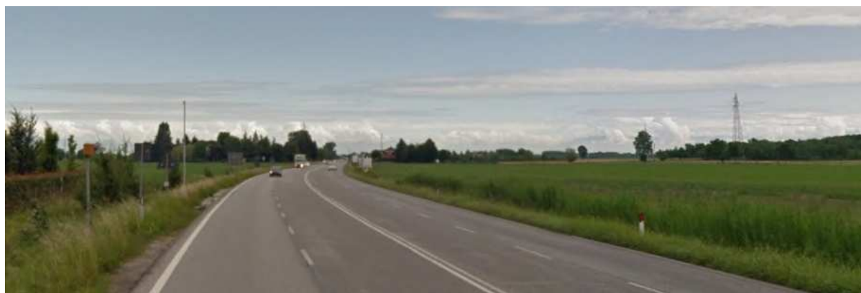
Figura 4.5 – SR308 "Nuova Strada del Santo"
