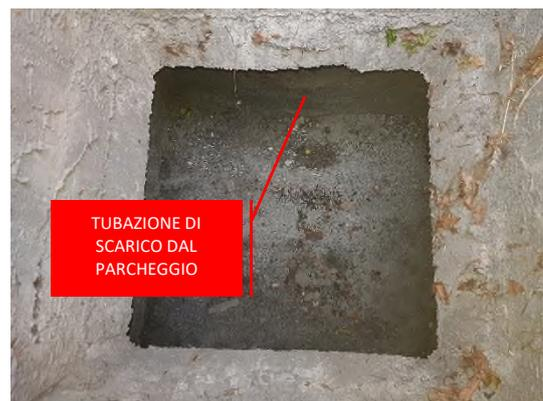
*Figura 2.2 – Vista interna del pozzetto di ispezione in linea di Figura 2.1*
