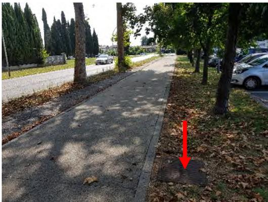
Figura 2.5 – Pozzetto di ispezione sul collettore tombinato DN 800 di via Valsugana
