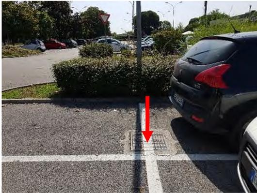
Figura 2.3 – Pozzetti di ispezione finale dal quale si dirama la tubazione DN400 CEM di scarico al di fuori dell'ambito
