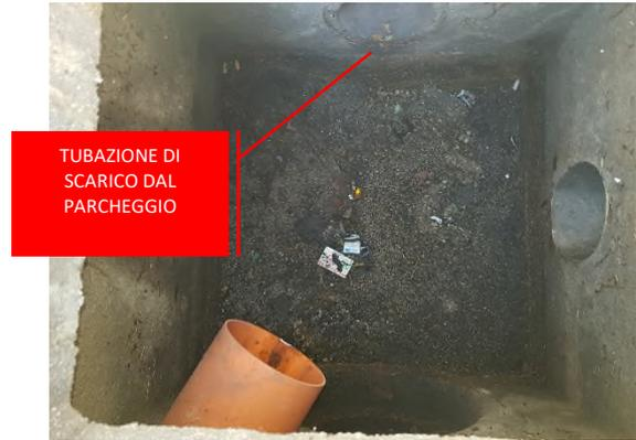
Figura 2.8 – Vista interna del pozzetto di ispezione di Figura 2.7
