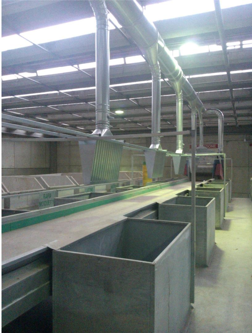
Le arie aspirate confluiranno ad una tubazione che le trasporterà all'esterno dell'edificio ove verrà posizionato un sistema di abbattimento a maniche filtranti. A seguito della depolverazione le arie verranno emesse in atmosfera attraverso un camino di emissione denominato C1 per il quale si richiede autorizzazione.
