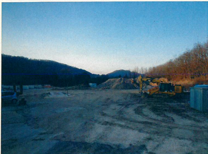
Vista impianto dall'accesso
