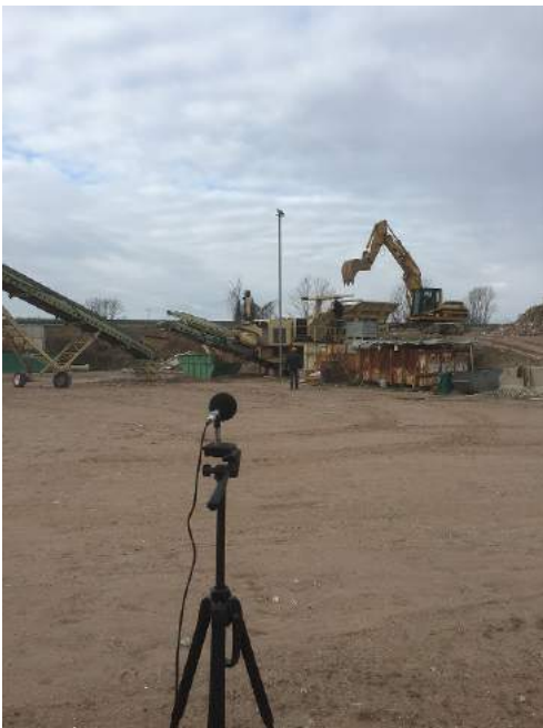
Misurazione attività escavatore e vaglio
