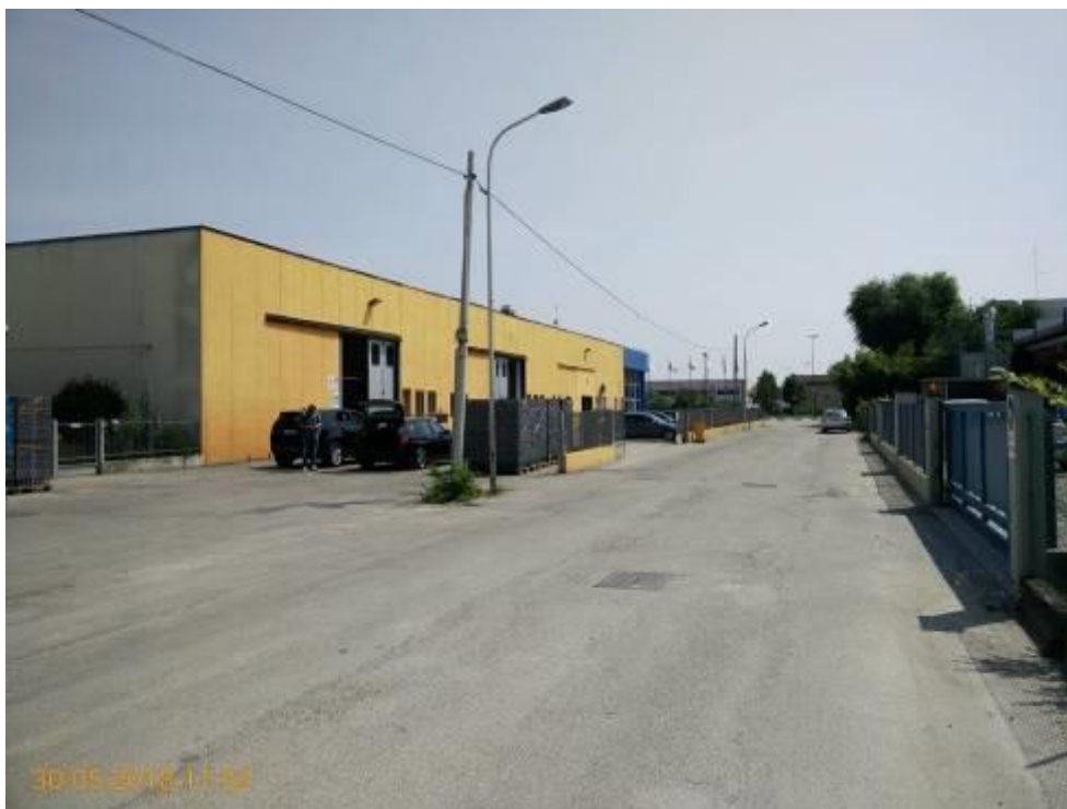
Foto 1 - Strada di lottizzazione – Via E. Mattei
