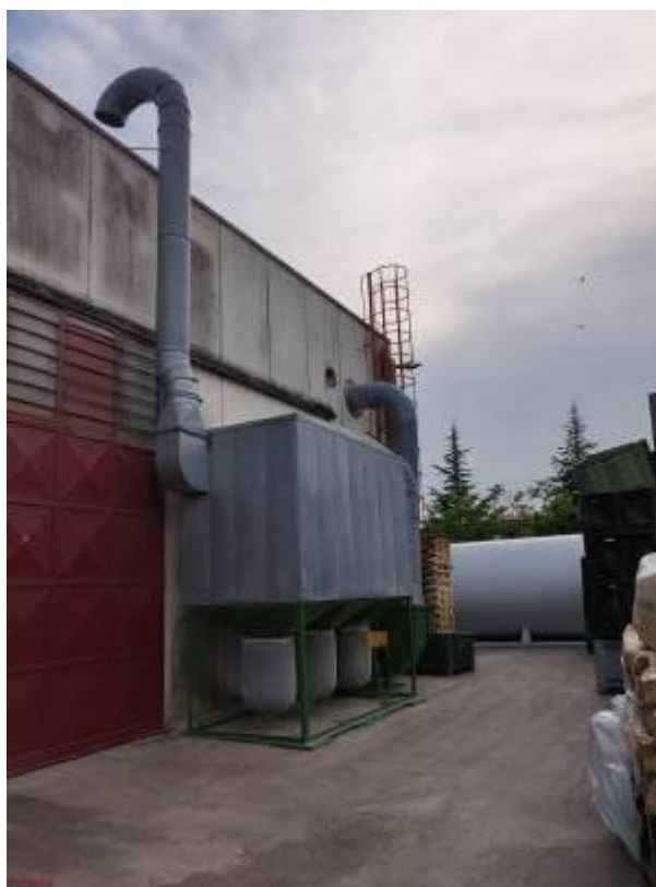
Foto 5 - Sistema di abbattimento polveri tramite filtri a maniche
