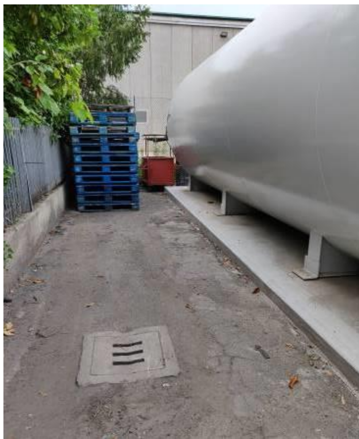
Foto 7 - Area deposito pallet (con vista caditoia acque meteoriche)
