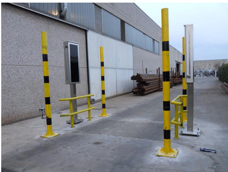
Figura 10 – Immagine esemplificativa del portale per il controllo radiometrico
