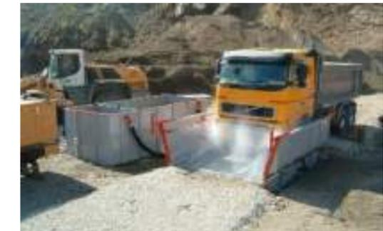
Figura 62: esemplificazioni di cannone mobile nebulizzatore d'acqua e di impianto lavar ruote.
