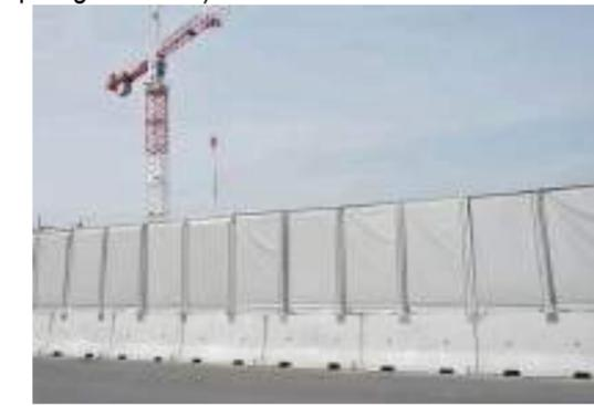
Figura 63: esemplificazioni di barriere provvisorie acustiche e antipolvere.
