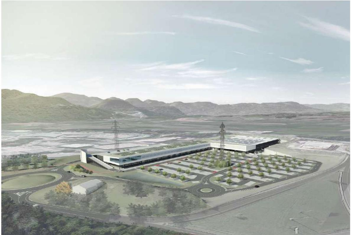
**Figura 10:** Progetto di variante -render di progetto vista da Nord-Est" – si vede il bacino di laminazione n°1 , il secondo sarà realizzato sotto il parcheggio
