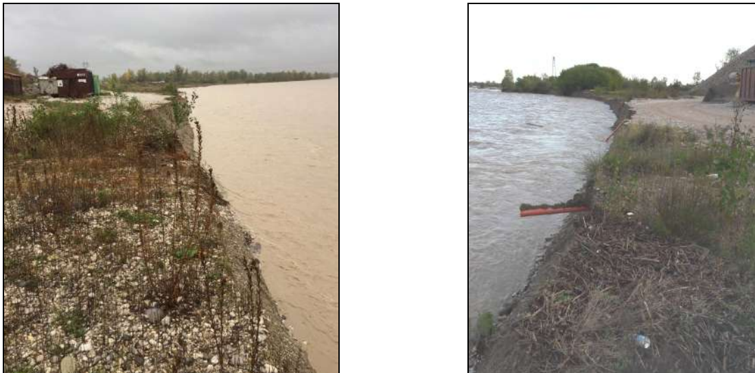
Figura 1 - Ondata di piena del Fiume Piave dello scorso ottobre/novembre 2018
