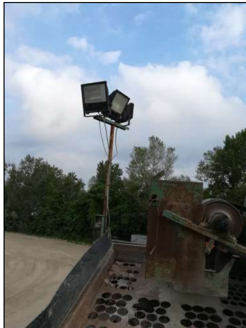
Figura 5 - Punto luce installato al di sopra del vaglio vibrante
