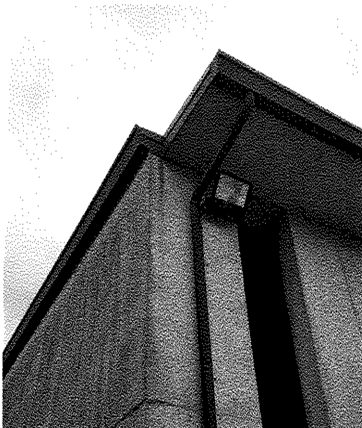
Foto 3 – fabbricato lato nord
