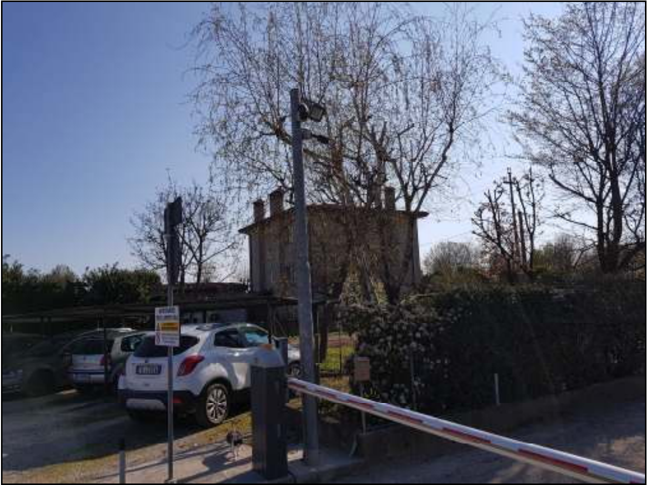
Foto 1: Punto 1 ingresso ditta - illuminazione a led durante le ore notturne
