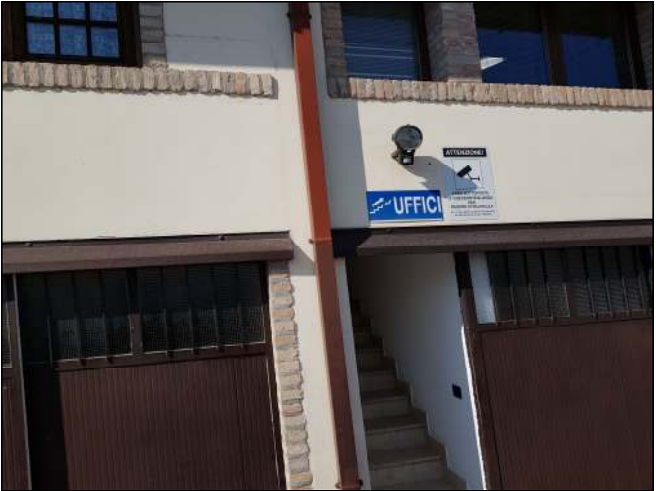
Foto 3: Punto 2 ingresso uffici - illuminazione a fotocellula (accensione e spegnimento solo in presenza di movimento)
