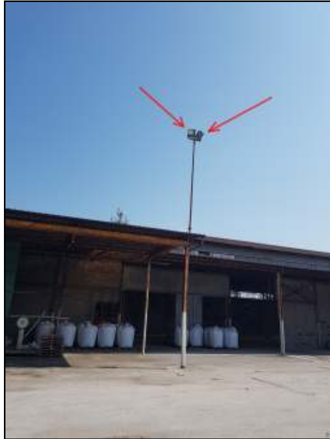
Foto 2: Punto luce 2 e 3 lampade alogene, accensione manuale, normalmente spenta
