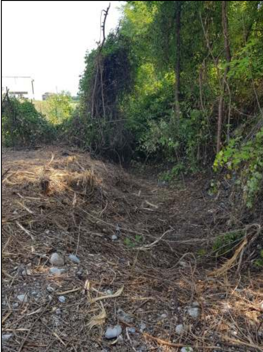
Foto 4: fossato parte iniziale
