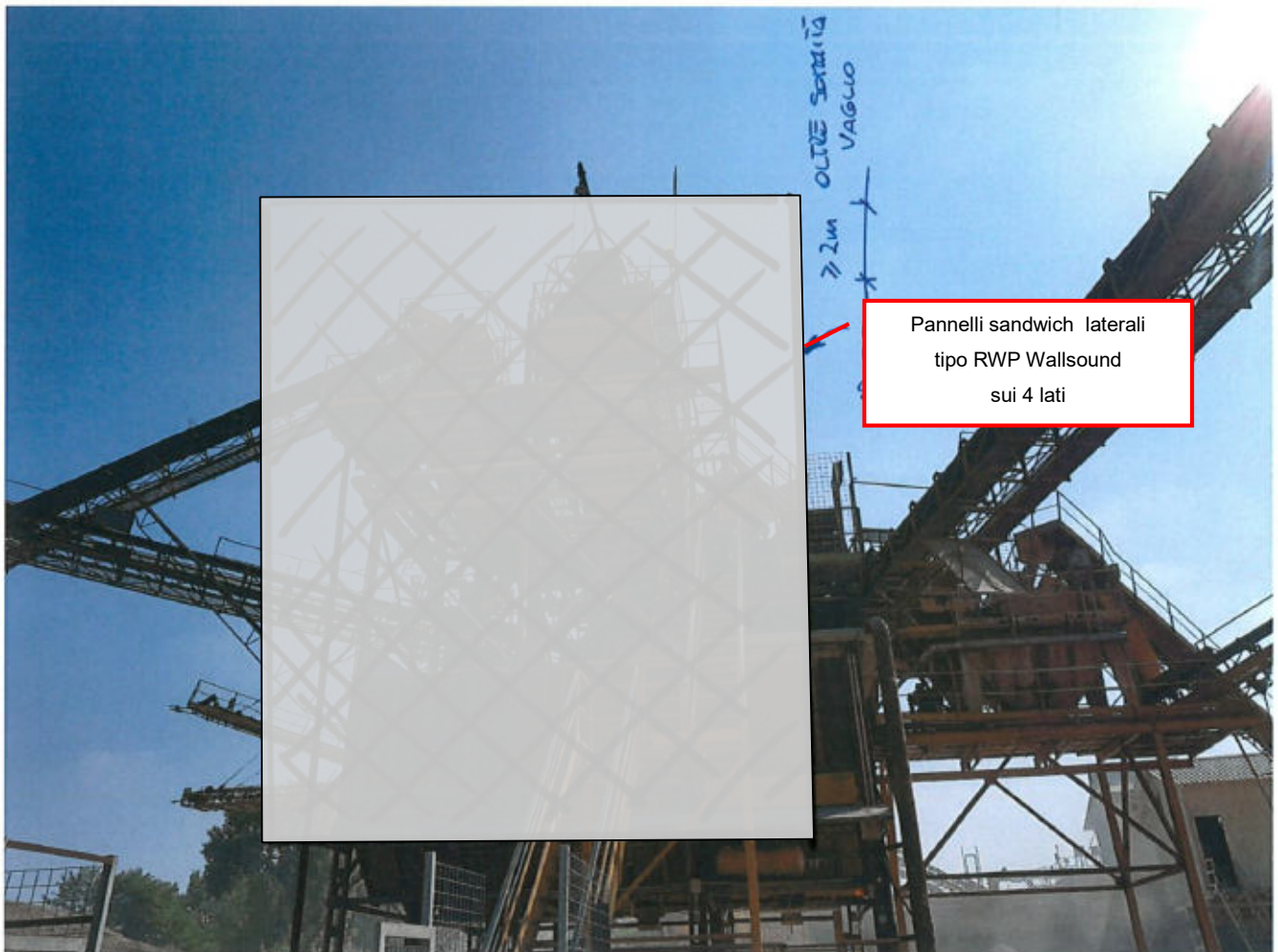
Vista esemplificativa della porzione di impianto da “tamponare” con pannelli Wallsound– vista zona NORD
