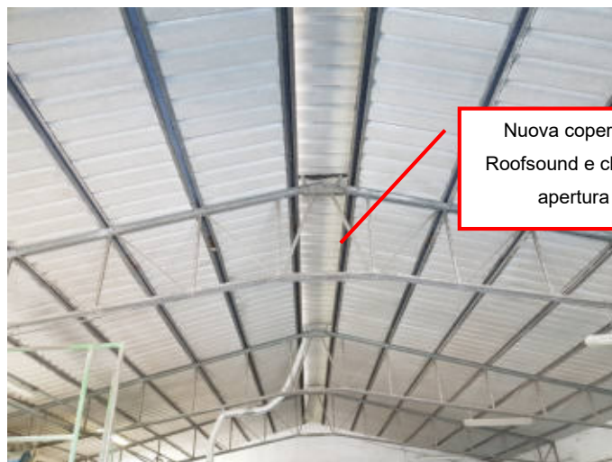
Nuova copertura in pannelli RWP Roofsound
