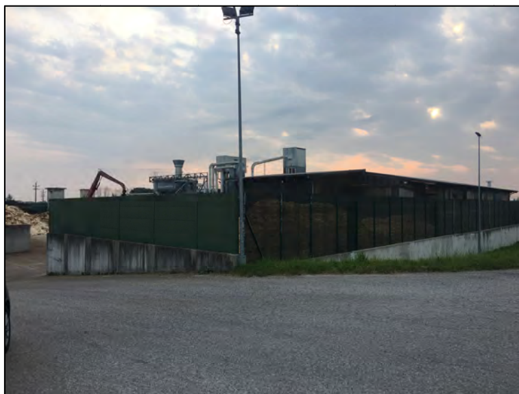
Figura 6.3. Vista dell'impianto dall'ingresso Sud-Ovest
