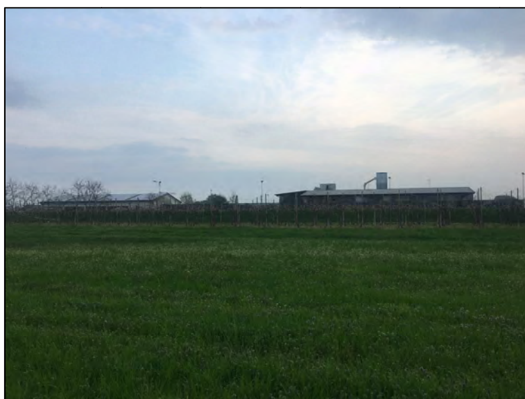
Figura 6.4. Vista dell'impianto e degli edifici limitrofi da Sud
