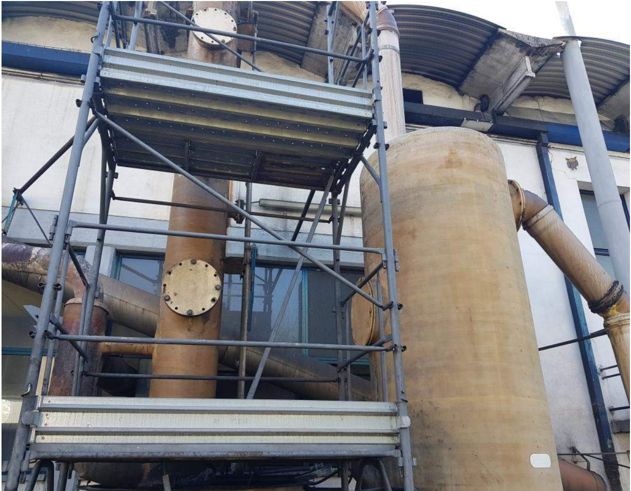
Foto 4 illuminazione al neon lato ovest vicino allo scrubber. Accensione manuale. È presente una tettoia a sbalzo
