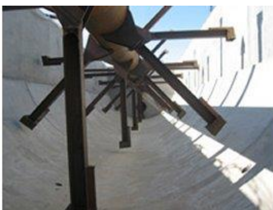
Figura 5. Esempio di miscelatore ad asse orizzontale
