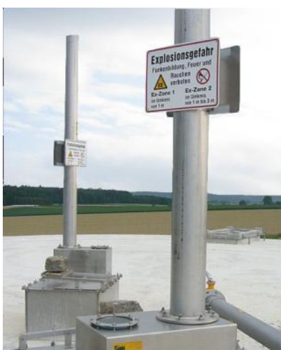
Figura 6. Esempio di guardia idraulica
