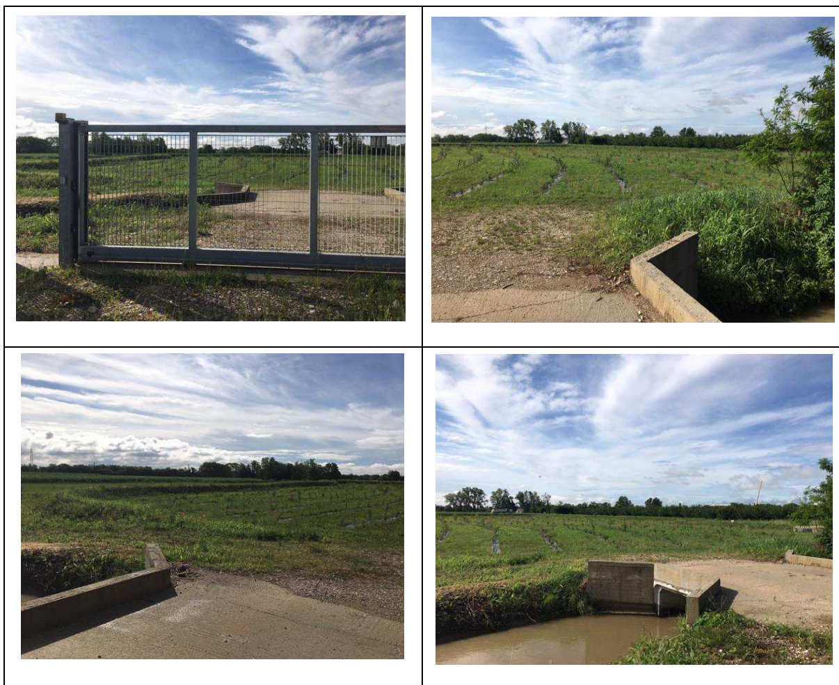
Figura 2. Foto recenti ponte P6 in prossimità dell’impianto
