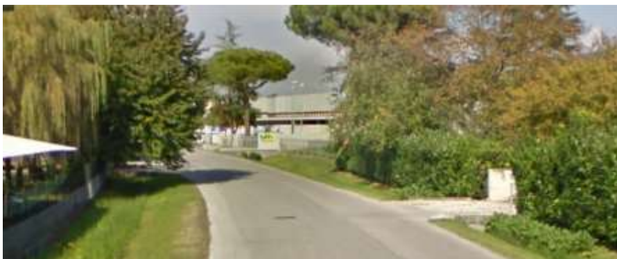
Figura 4-2- Tratto finale Viale delle Industrie con sede stradale e fossi laterali
