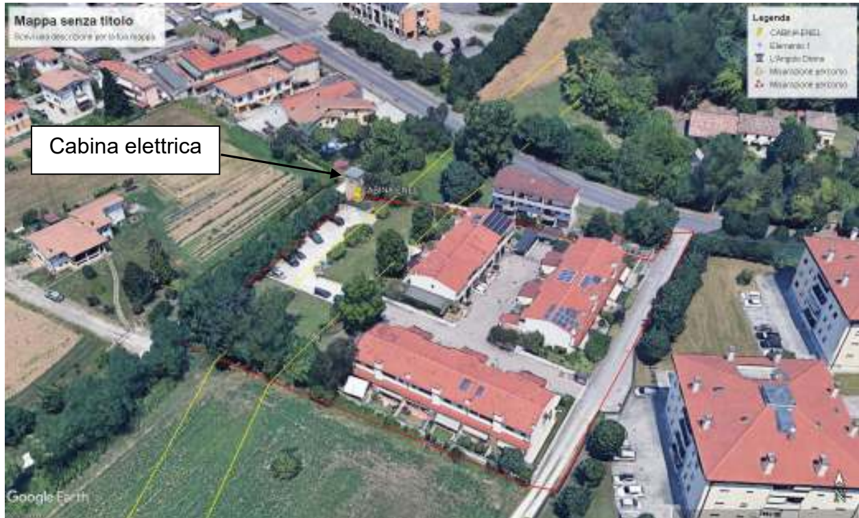
Foto 2 estratto da Google con indicazione della cabina e del sedime stradale
