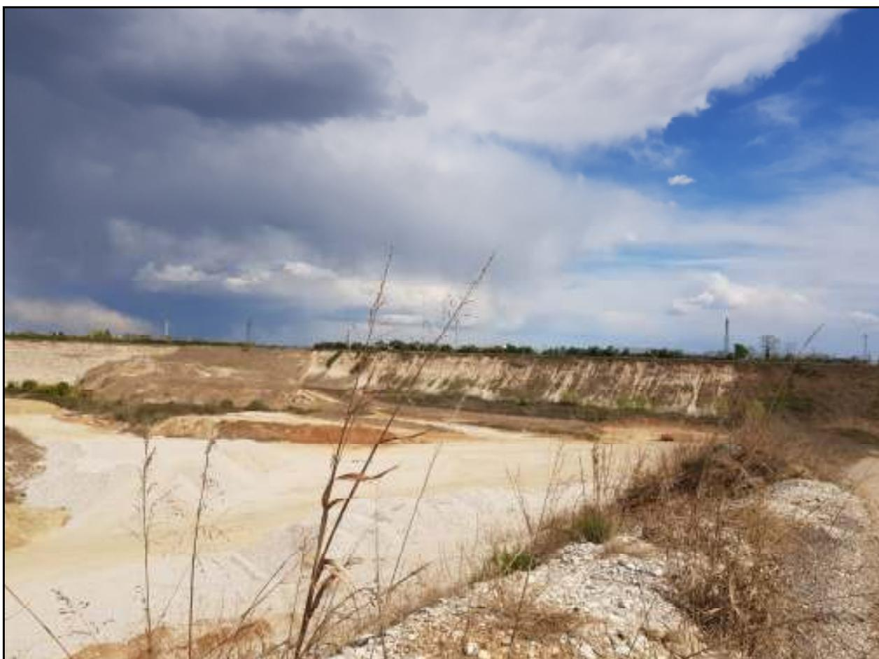
*Figura 1: scarpata Nord Est, il cumulo di terreno accatastato e proveniente dalla Superstrada pedemontana sarà utilizzato per la ricomposizione della scarpata stessa come da cronoprogramma, I cumuli di ghiaia in primo piano saranno utilizzati per la viabilità (questa è la porzione di cava interessata dal progetto)*
