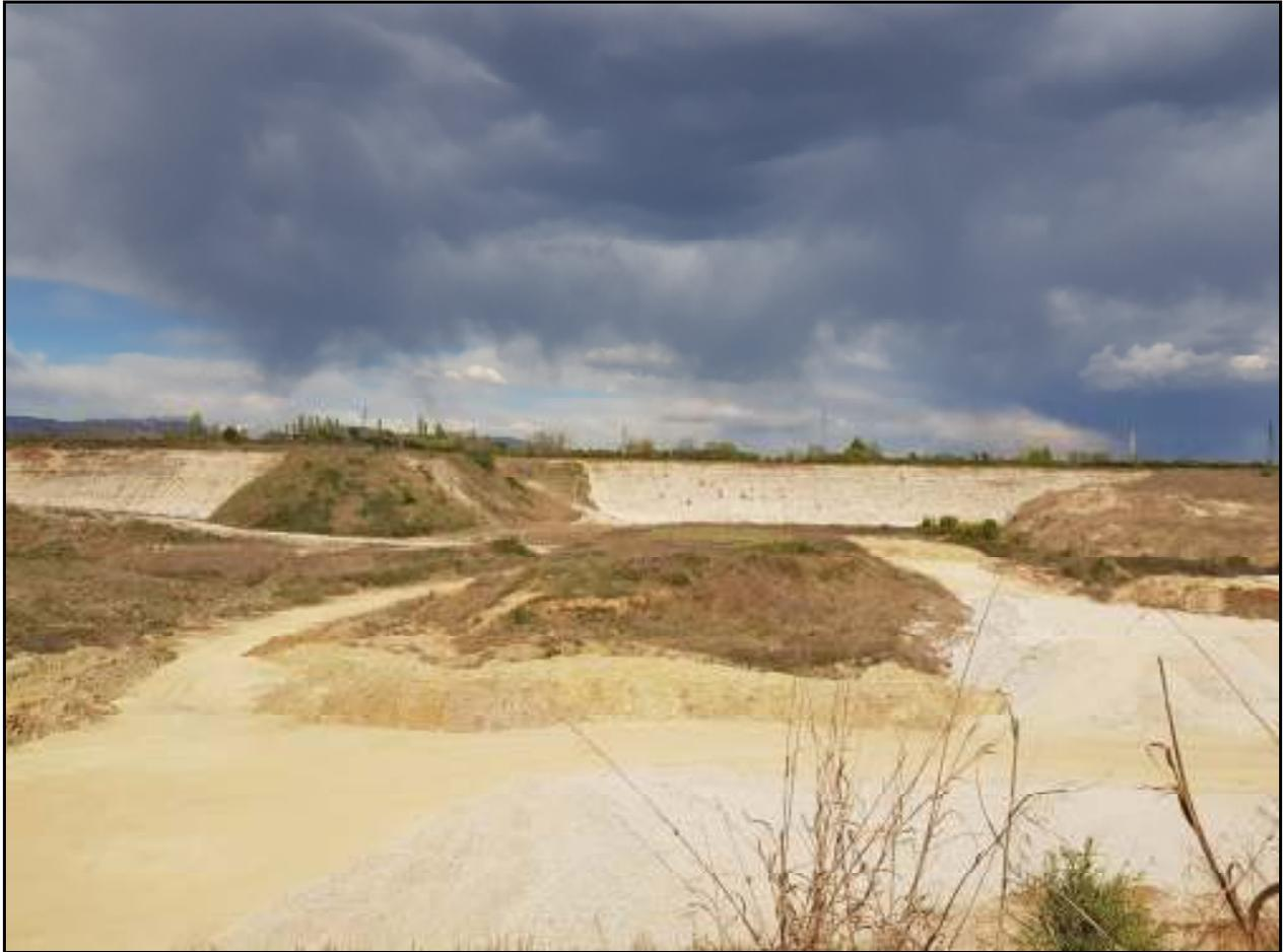
*Figura 2: scarpata Nord, sarà ricomposta come da cronoprogramma, il cumulo di terreno proviene in larga parte dai lavori della Superstrada Pedemontana Veneta e in misura minore da scavi del Gruppo Grigolin*
