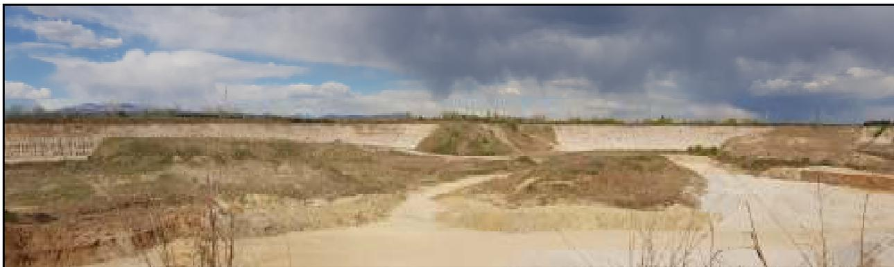
Figura 4: panoramica scarpata Nord e Nord Ovest, la scarpata Nord Ovest, in parte, dovrà essere ricomposta a 4 metri dal piano campagna (la zona a sinistra in foto dove il terreno di ricomposizione è in quantità maggiore)
