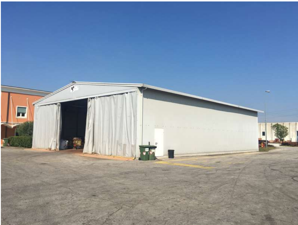
Fabbricato esistente per l'attività di recupero e messa in riserva dei rifiuti nell'area del Comune di Preganziol
