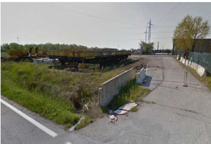
Accesso esistente da Via della Croce
