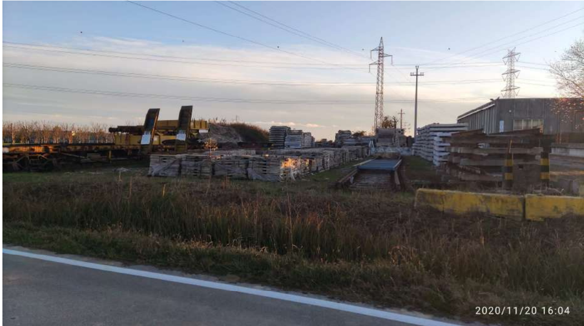
Foto 04 (area oggetto intervento da Via Croce)
