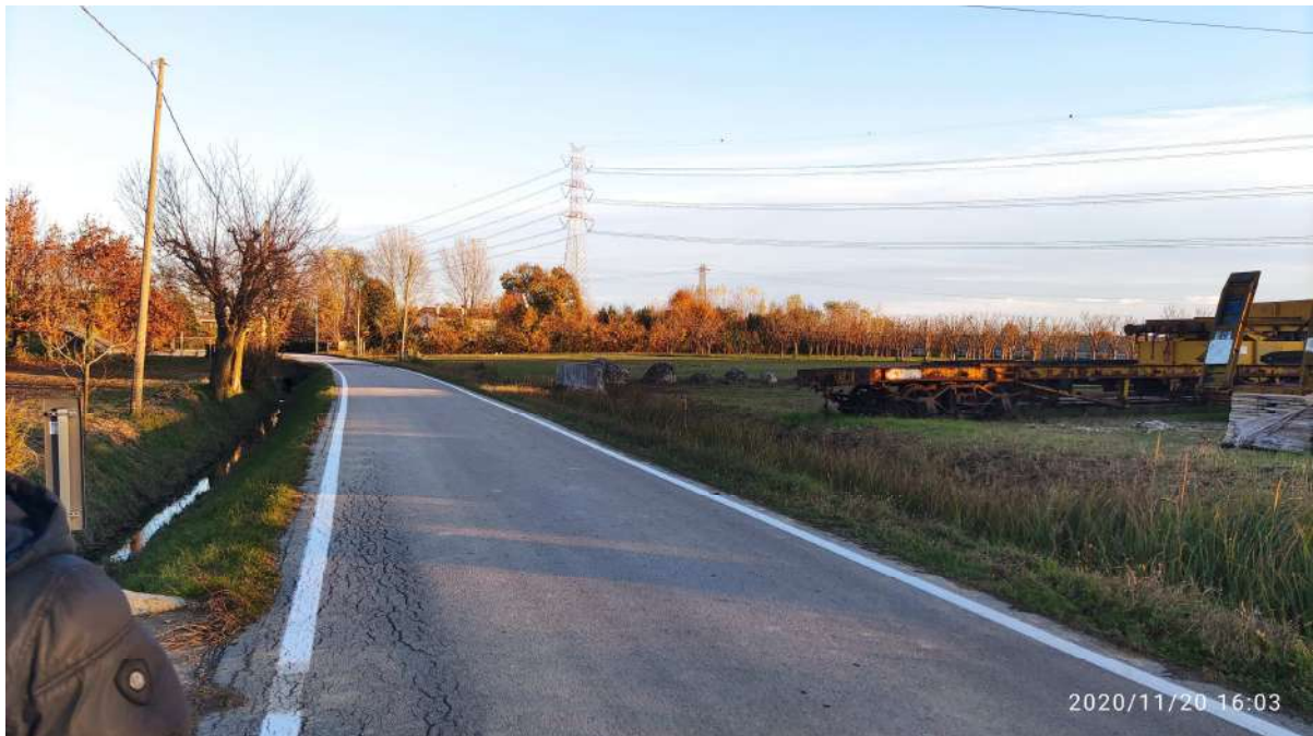
Foto 058 (area oggetto intervento da Via Croce)
