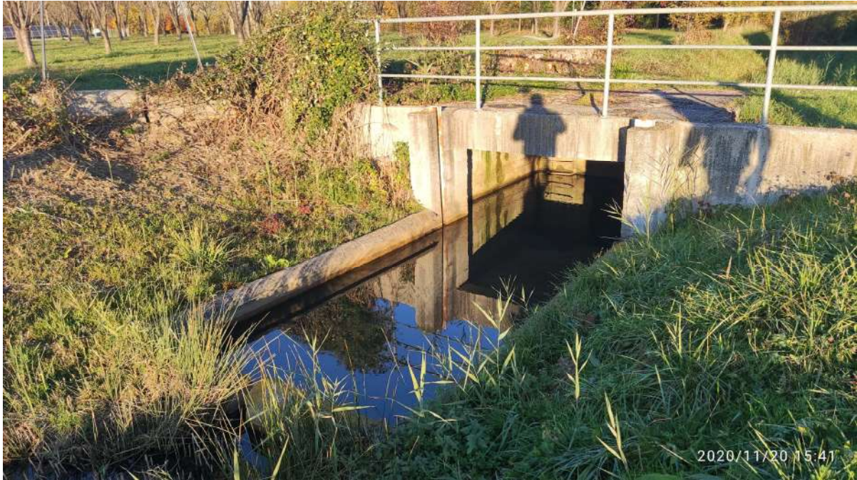
Foto 01 (ingresso sifone sotto autostrada)
