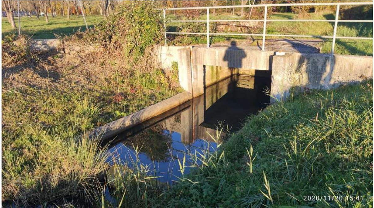
Foto 01 (ingresso sifone sotto autostrada)
