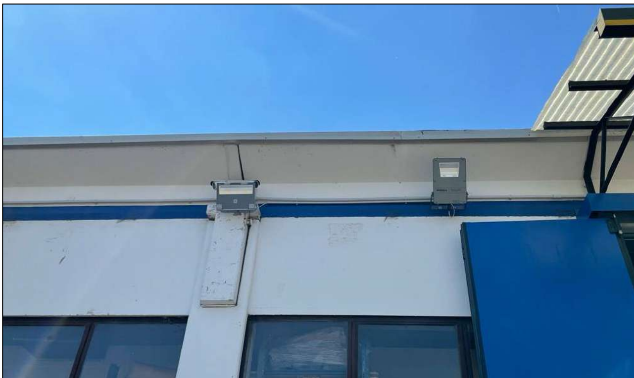
Figura 4: Punti luce sul lato est dell'autorimessa (riferimento cono visuale n.3)
