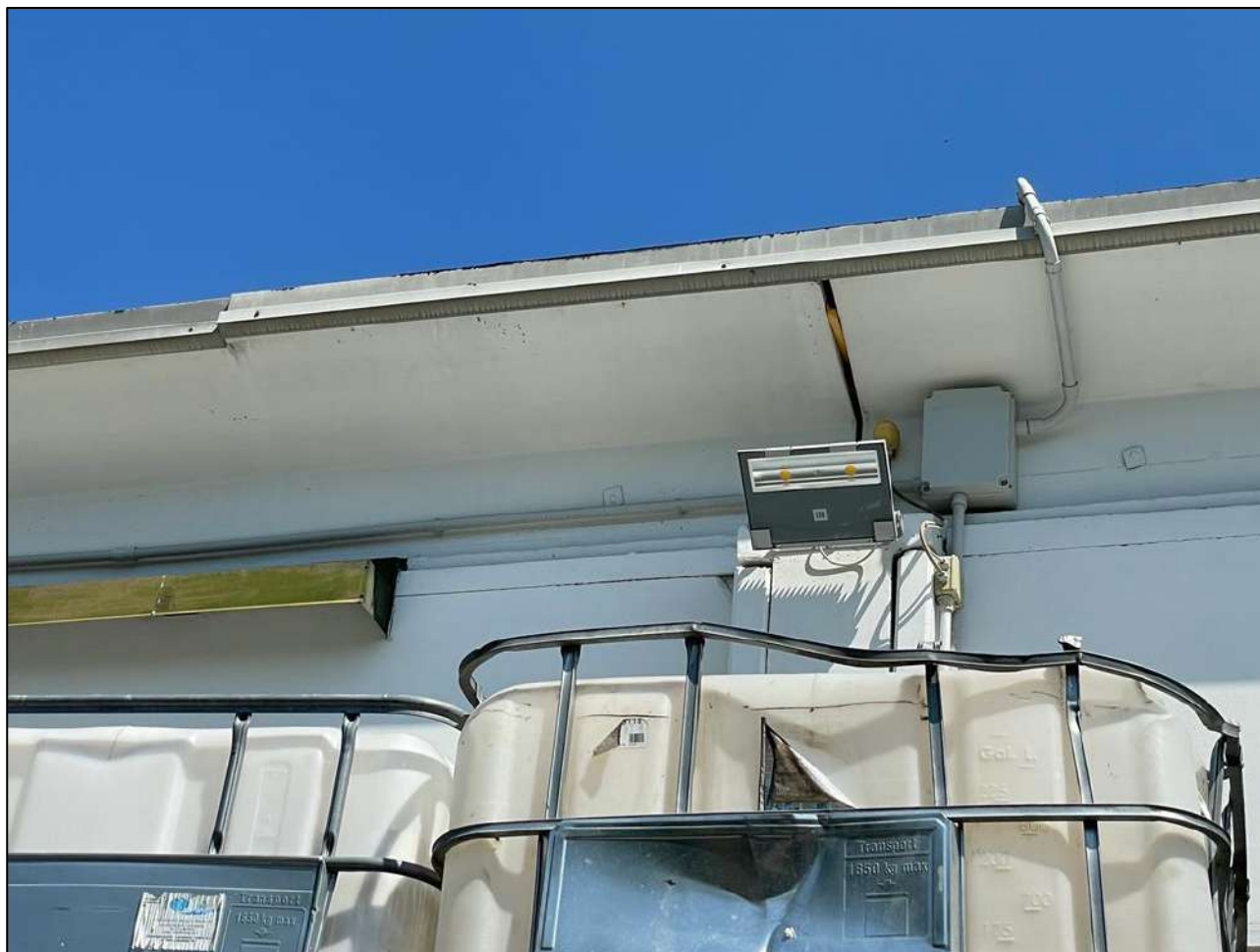
Figura 7: Punto luce sul lato ovest dell'autorimessa (riferimento cono visuale n. 6)
