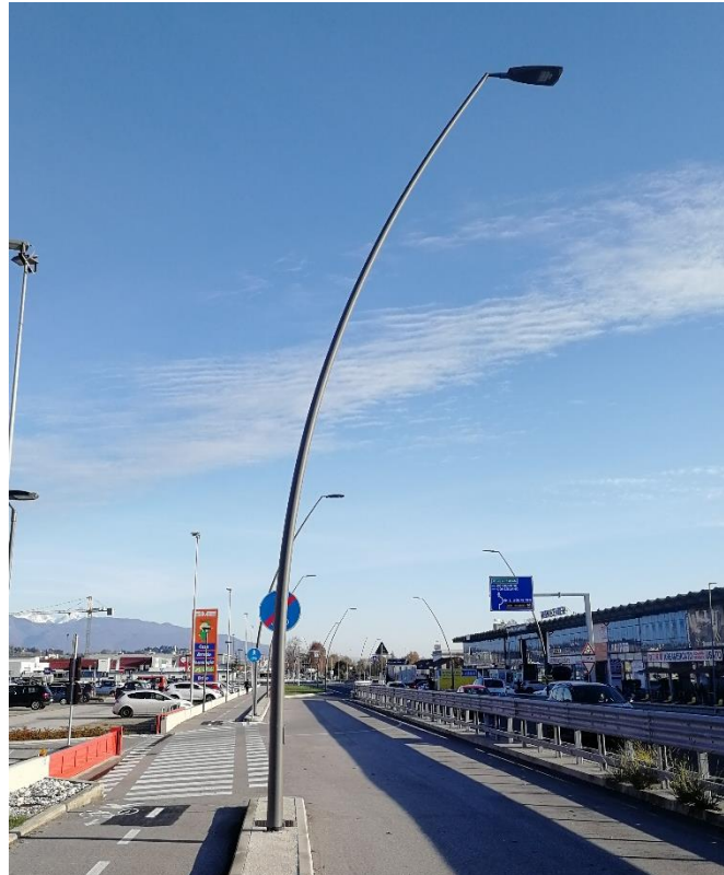
Figura 3: Illuminazione esistente lungo la S.S. 13
