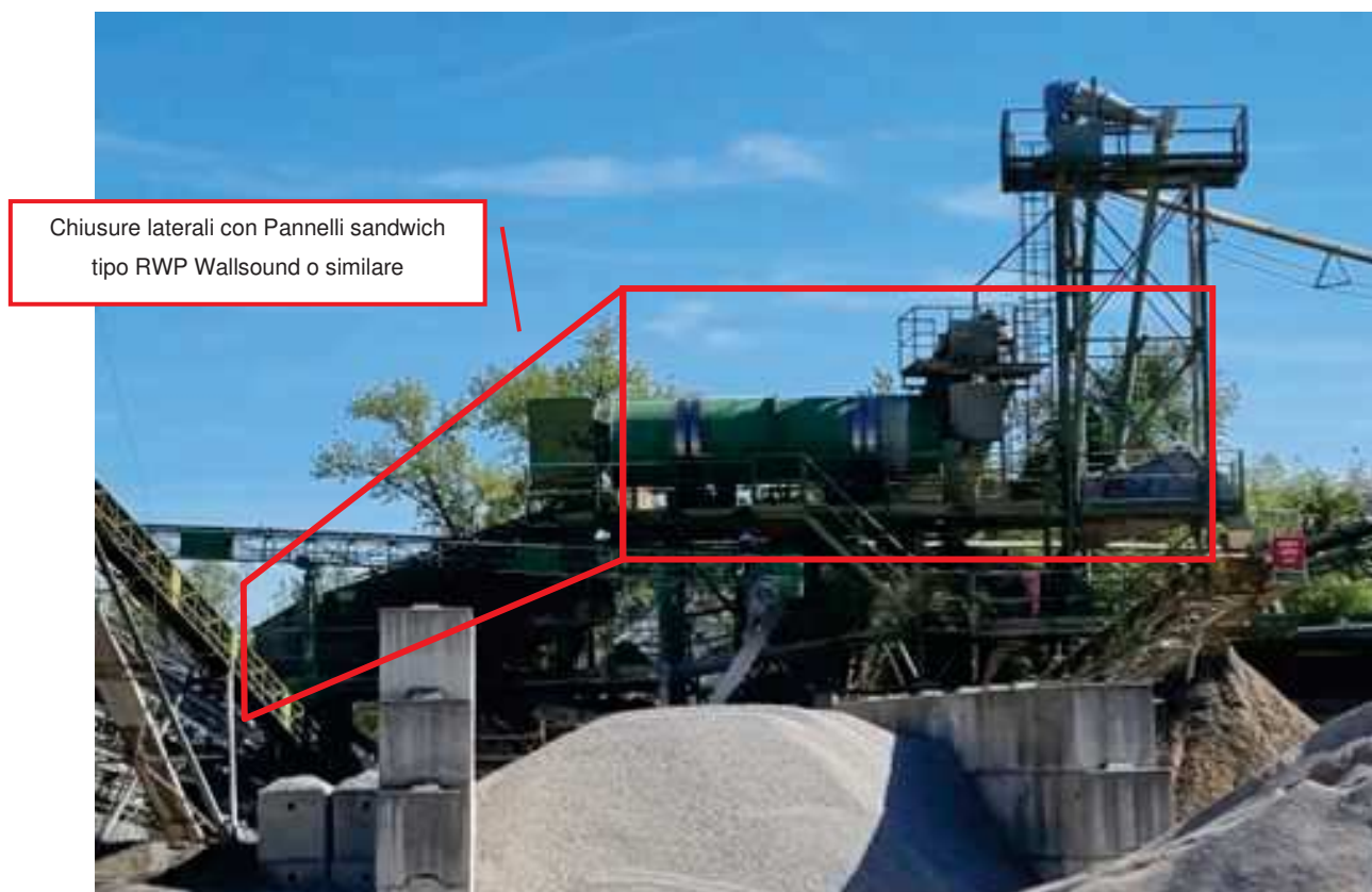
Tamponamenti laterali Impianto Ghiaia con pannelli wallsound
