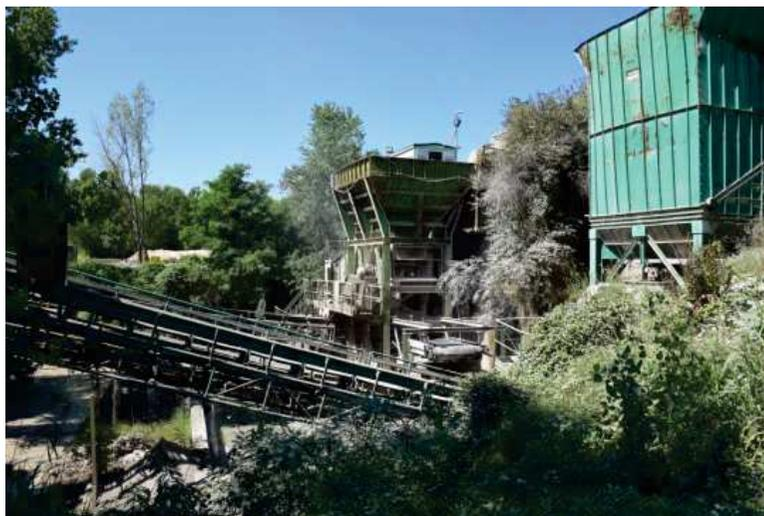
Figura 4-3: Impianto di trattamento rifiuti inerti allo stato attuale
