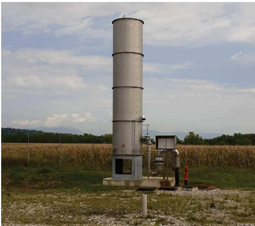
Figura 4: Torcia biogas.
