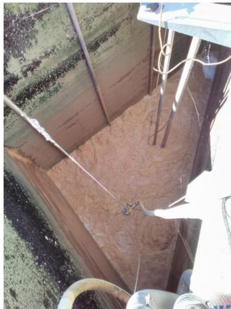
Figura 11: Vasca di decantazione
