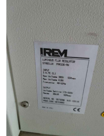
REGOLATORI DI LUMINOSITÀ PER FARI DA 400W SUL PERIMETRO CIRCUITO 2
