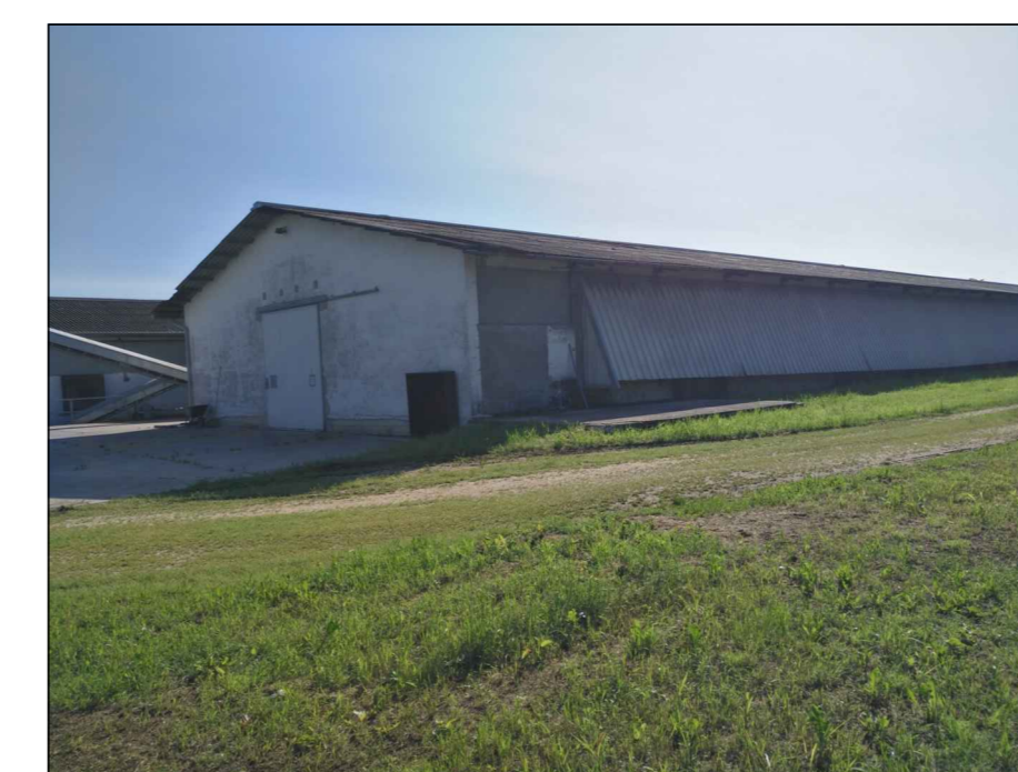
Foto 8 Capannone 1 galline ovaiole in gabbia
