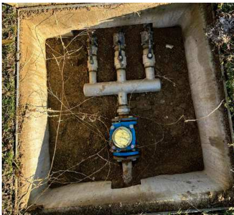
FOTOGRAFIA MANDATA POZZO - MISURATORE E RETE DISTRIBUZIONE
