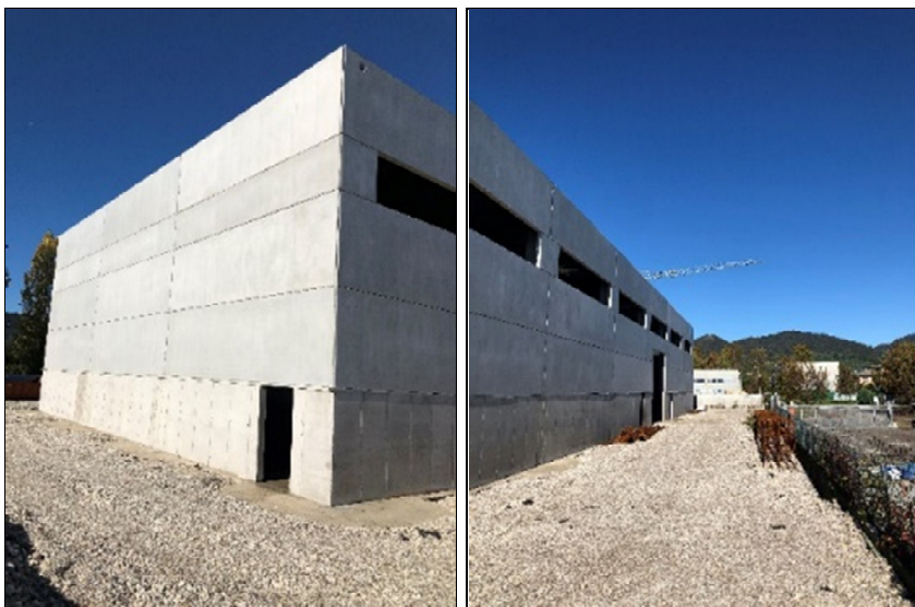
Angolo nord ovest del fabbricato (novembre 2023)
